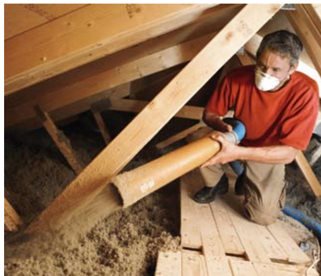
Granulat, som blæses ind på loftet.
